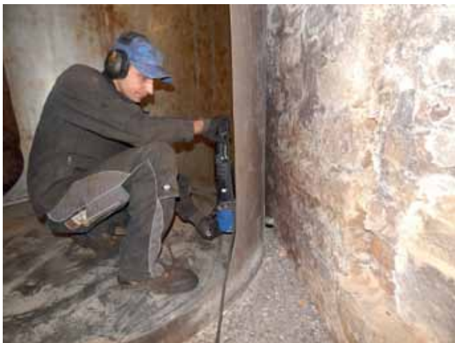
Mit dem Nibbler TruTool N 700 schneidet Angelo Lenhart die Tanks in handliche Streifen.
